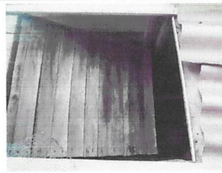
FOTO 8: VENTANA DE MADERA EN MAL ESTADO SIGNIFICANDO INSEGURIDAD PARA EL RESGUARDO DE LOS ALIMENTOS
